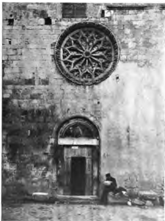
ALBA FUCENSE — PARTICOLARE DELLA FRONTE DELLA CHIESA PARROCCHIALE. (Fot. Gargioli).
